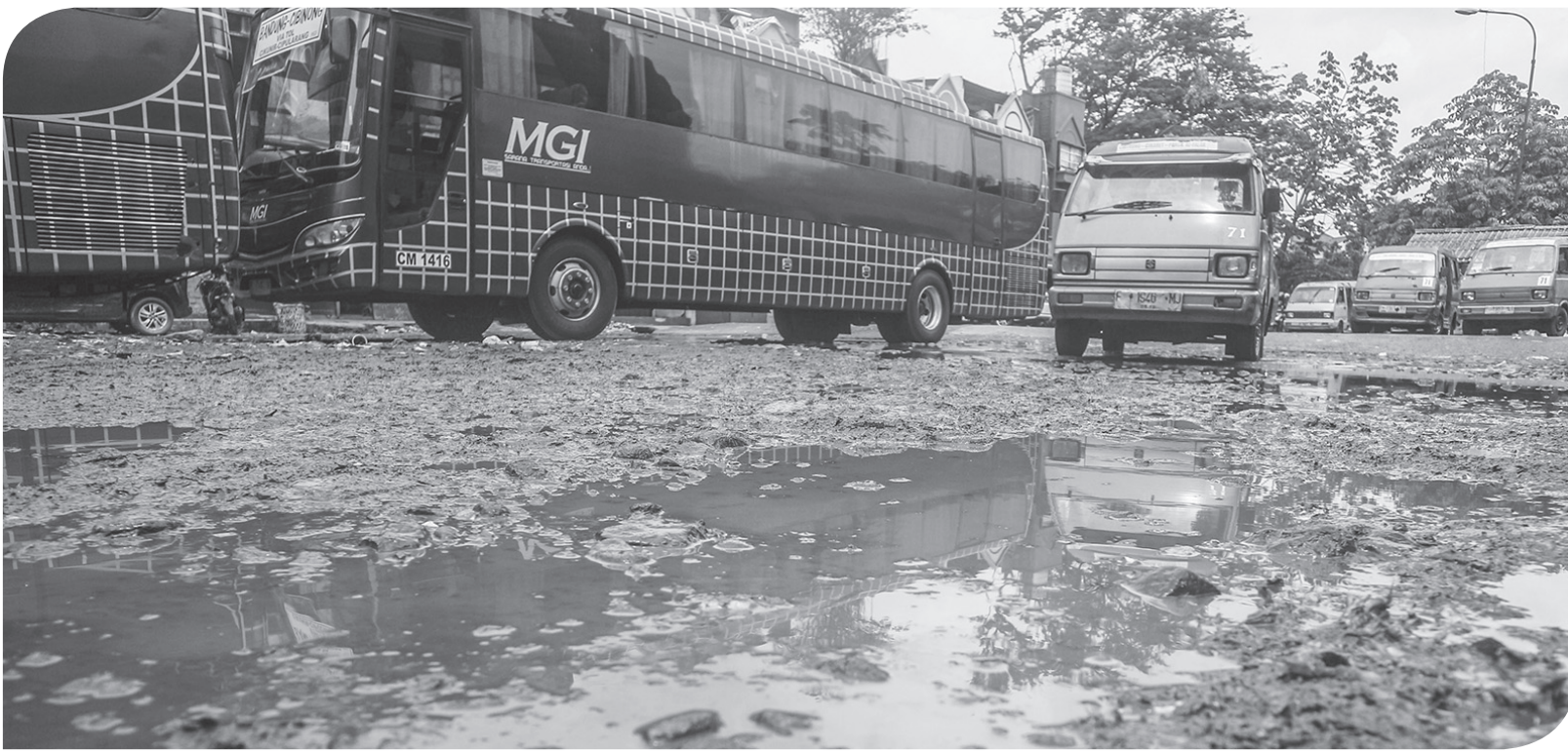
TERMINAL RUSAK DAN TIDAK TERAWAT
